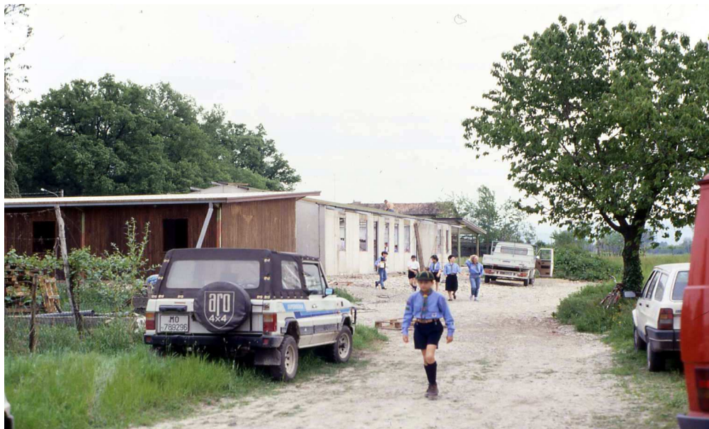
I prefabbricati in fase di montaggio a Magreta: 1988-1989
